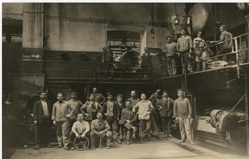
Εργαζόμενοι της Ελληνικής Ηλεκτρικής Εταιρείας κατά την εγκατάσταση γερμανικών λεβήτων στον Ατμοηλεκτρικό Σταθμό του Νέου Φαλήρου, 1917
